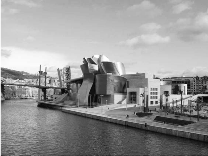
Abbildung 7.4: Guggenheim Bilbao (Quelle: http://architetur.files.wordpress.com/2009/11/guggenheim-bilbao-1.jpg )
